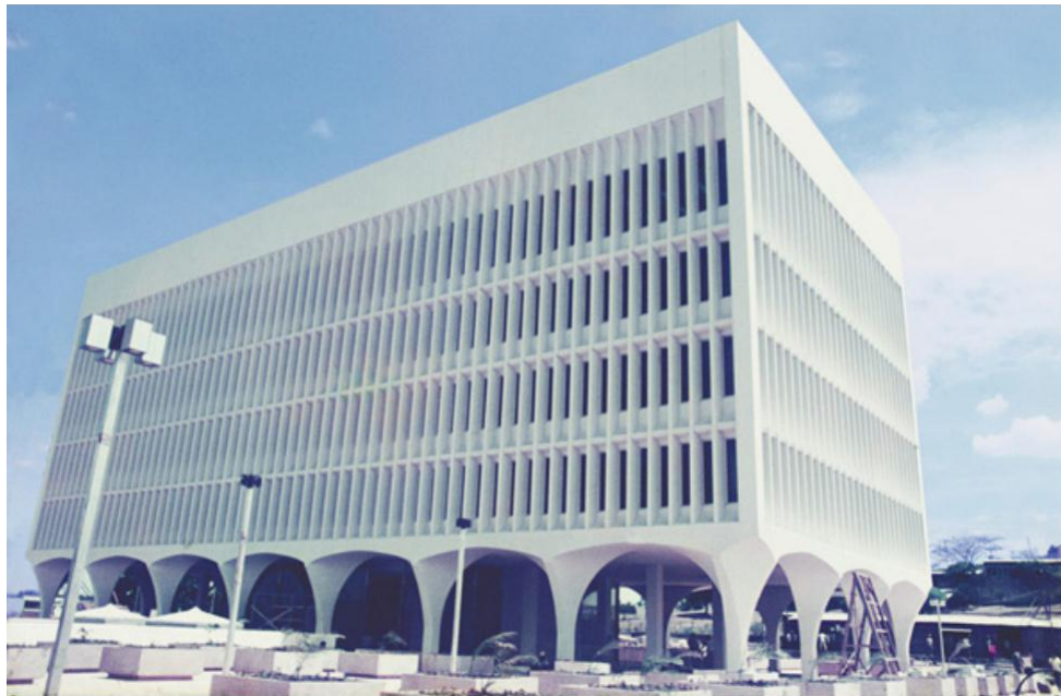
Edificio ENALUF: http://www.fsa.cr/proyectos_ing_s_publico.htm
